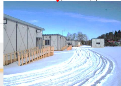
胆振東部地震福祉仮設住宅(厚真地区) / P017
